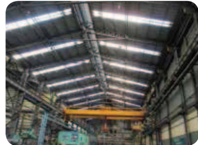
廠房高空照明改善
