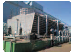
CT901 冷卻水塔汰換
