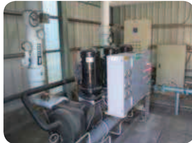
生產大樓冰水機管路更新
