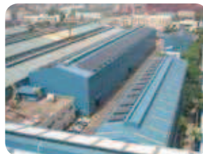
450KW 太陽能建置
