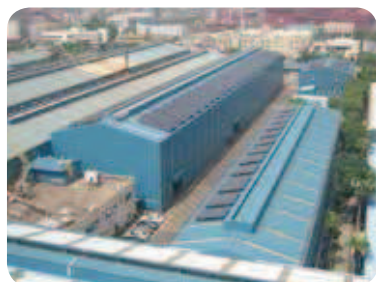
太陽能發電系統
