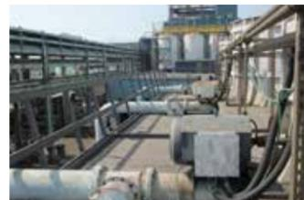
冷卻水塔風扇變頻化
