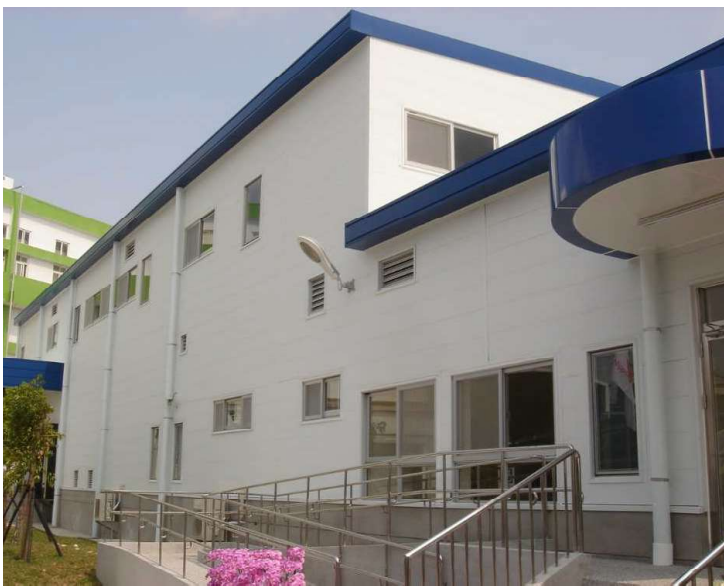
▲外牆板完工照。
