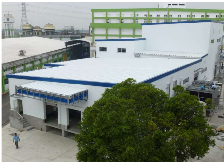
▲屋頂板完工照。
