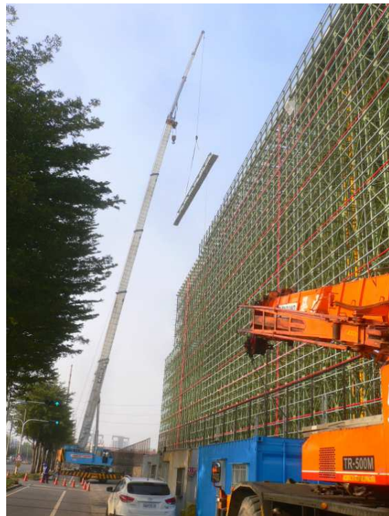
▲ 屋面板進場吊料。
