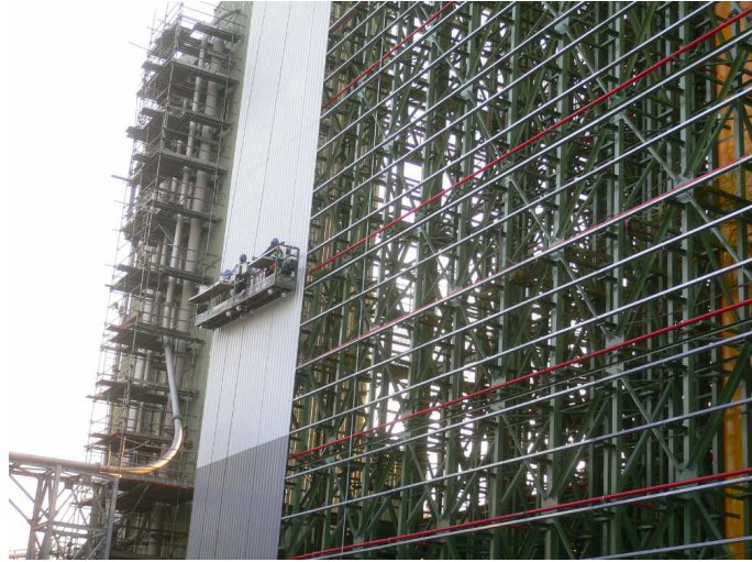
▲外牆橫向色帶安裝作業。
