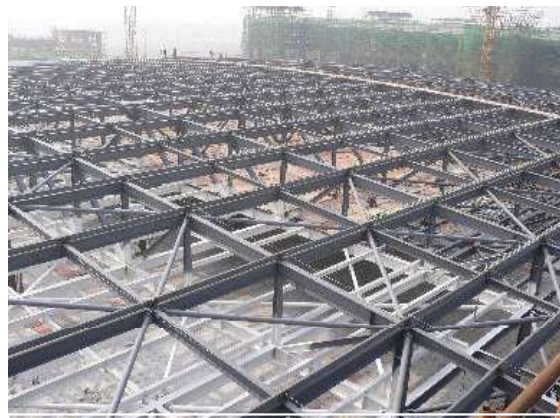
▲ 安裝前鋼結構
