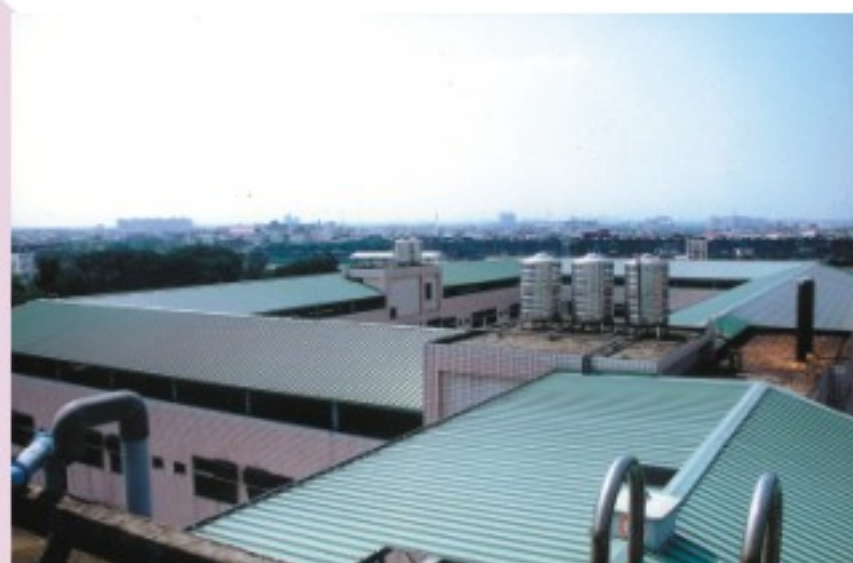
▲北部某家安養中心
