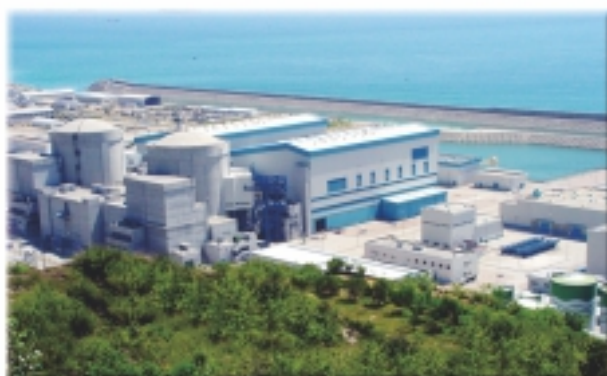
■ 大陸核電廠 Nuclear Power Plant, China
